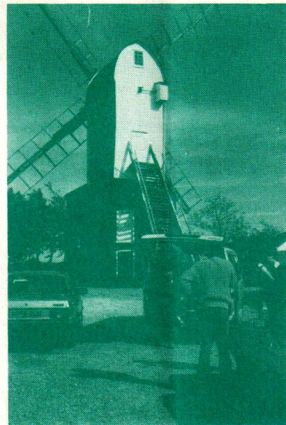
Een kop Engelse thee bij de molen van Ramsey, met zijn typische hoge onderbouw. Het kastje aan de achterzijde behoort bij de vroeger aanwezige windroos op de nok van het dak. Gevlucht zonder klepjes.
