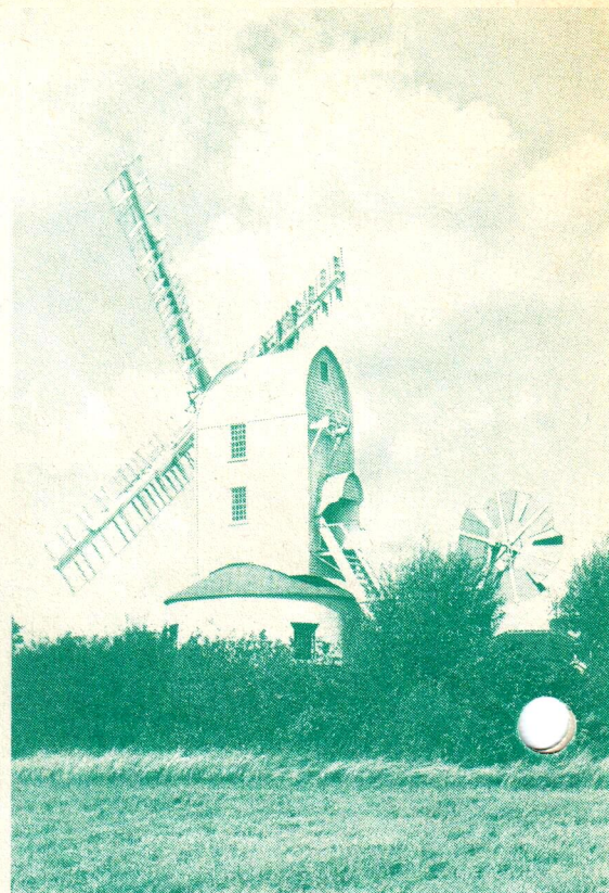
De standerdmolen van Saxtead Green, met zijn witte kast en blauwe windroos. De omlijsting van ramen en deur is apart. Het kettingwiel is voor het regelen van de kleppen.
