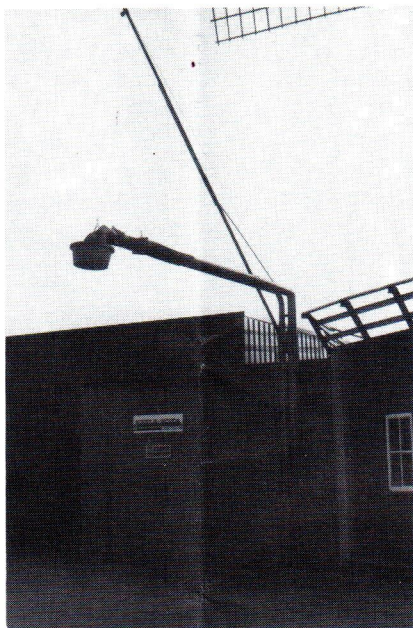
De aanvoerleiding voor het produkt en de afvoerleiding voor lucht die door middel van een cycloon wordt gefilterd.
