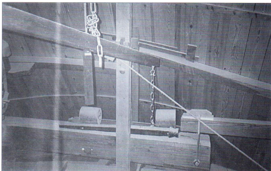
Vangbalk boven het voeghout, met linksboven de binnenvangstok
