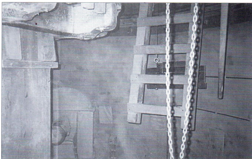
Uitschuifbare kippetrap met daarachter de contragewichten. Achterin links de nieuwe stalen elevator.
